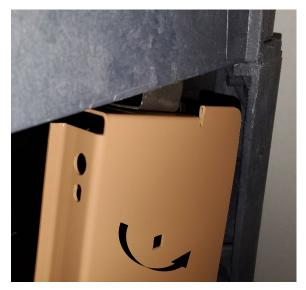
TUCK THE PANEL IN FROM THE TOP MAKING SURE SMALL BRACKET IS BEHIND THE TOP LIP SWIVEL PANEL DOWNWARD TO ALIGN PANEL WITH CORNER CLAMP
